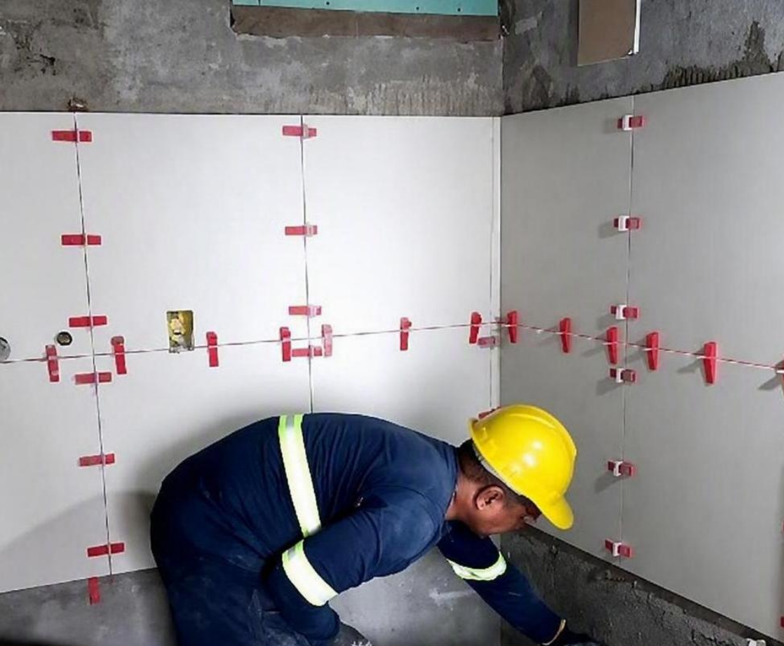
Assentamento com clipe nivelador e conferência dimensional — área molhada de unidade assistencial
