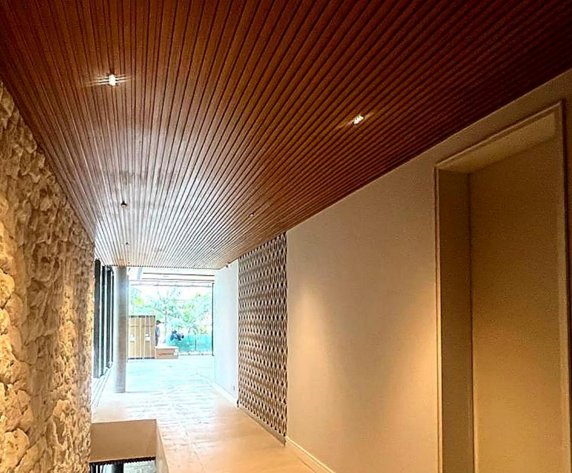
Corredor principal — pedra moledo + forro ripado em madeira
